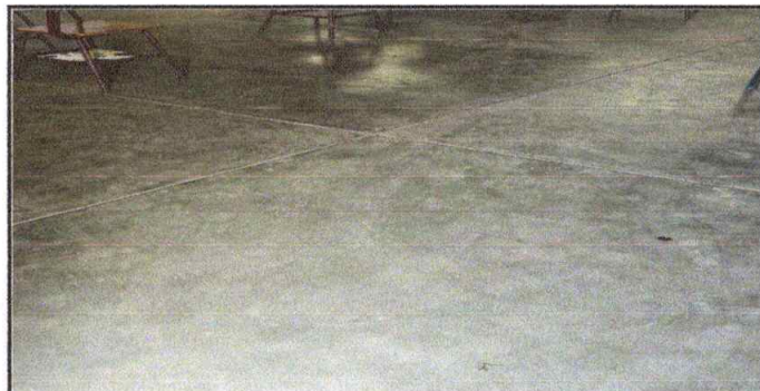
Foto 6: Sustrucción de piso de cemento líquido por cerámico mas nivelación
